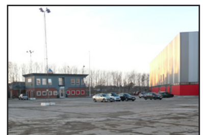
Ældre kontorbygning syd for Arenaen, som i dag er indrettet til klinik.
