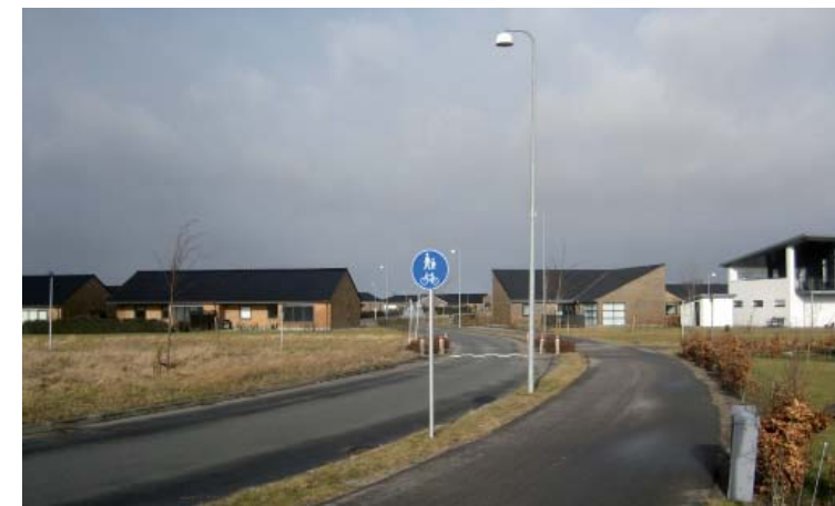
Et nyere boligområde, hvor belysningsmateriellet er tilpasset vejenes funktion og karakter. Her er masten lidt højere på de primære boligveje end på de sekundære. Belysningen er velafskærmet og nedadrettet - og belysning af cykel- og gangstien langs vejen er tilgodeset
