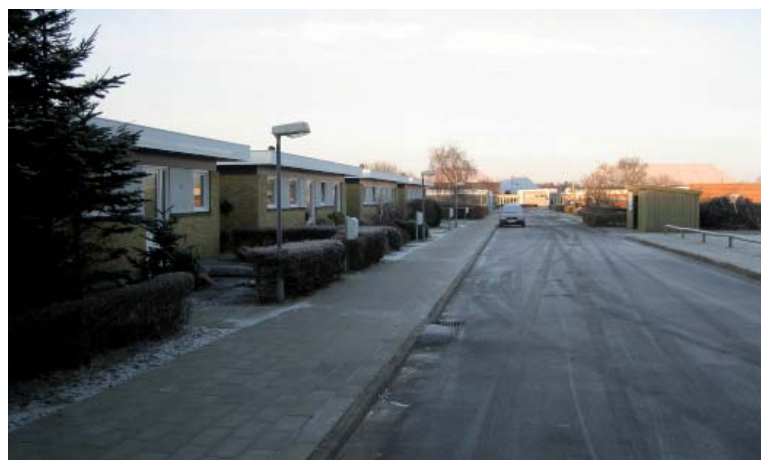
Et ældre rækkehusområde, hvor belysningsmateriellet ligeledes er af ældre dato - mastehøjden er meget lav, ca. 2 meter
