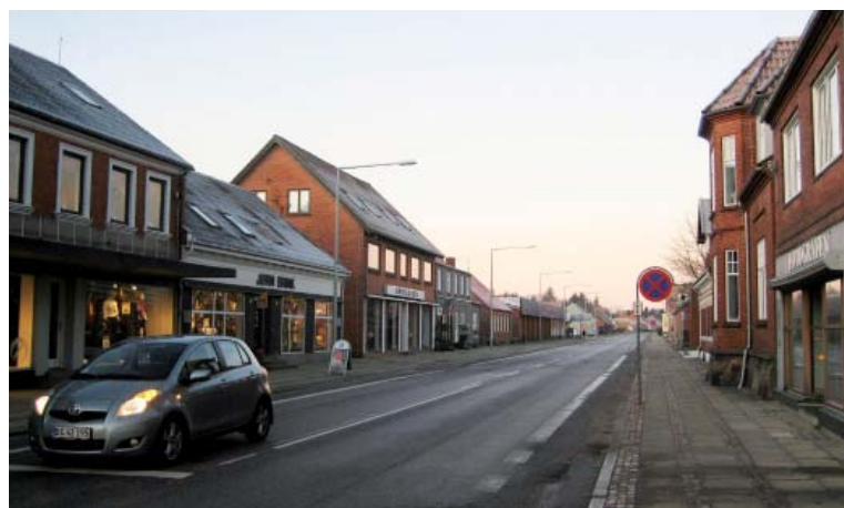
Harbogade er en af de overordnede veje i Ulfborg og fungerer samtidig som en bygade, hvor husene ligger ud til vejen og skaber et veldefineret gaderum. De lange mastearme er ikke tilpasset byrummets skala
