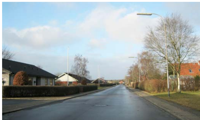
Et ældre boligområde fra 1970'erne, hvor belysningsmateriellet er utidssvarende. Mastehøjden, mastearmens længde og armatur signalerer overordnet vej, hvor vejen reelt er en primær boligvej med begrænset trafikmængde og lav hastighed
