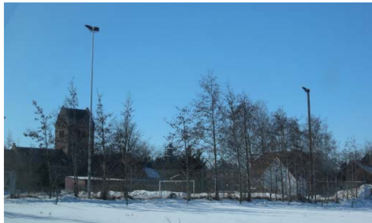
Belysning af eksempelvis idrætsarealer bør ske ved armaturer med nedadrettet belysning og plan skærm. I dette eksempel er armaturernes lysåbning vendt skråt opad og en stor del af lyset rettes derfor hen hvor det ikke skal bruges og skaber lysforurening og blænding
