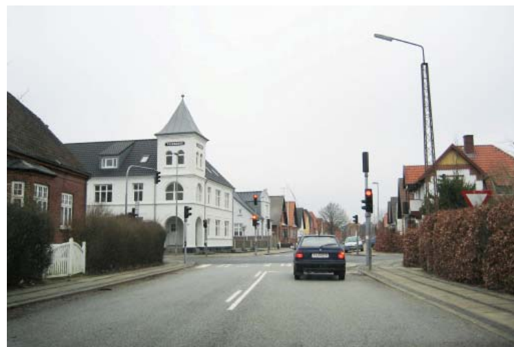
Eksempel på et ældre belysningsanlæg i Holstebro
