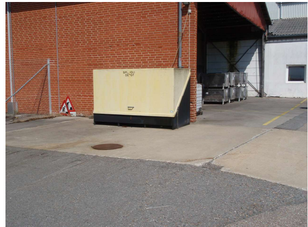
Foto 4: Område ved olietank T30 (nedgravet ved dæksel).
